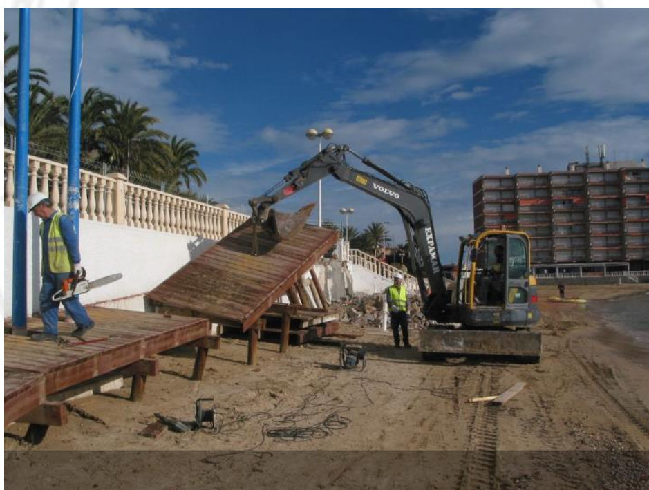
Obras de emergencia para reparar los daños producidos por el temporal de diciembre de 2014 en la playa de Los Locos (Suances, Cantabria).
